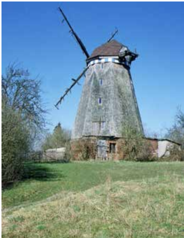
Sockelgeschoß- holländermühle von Osten, März 2005
