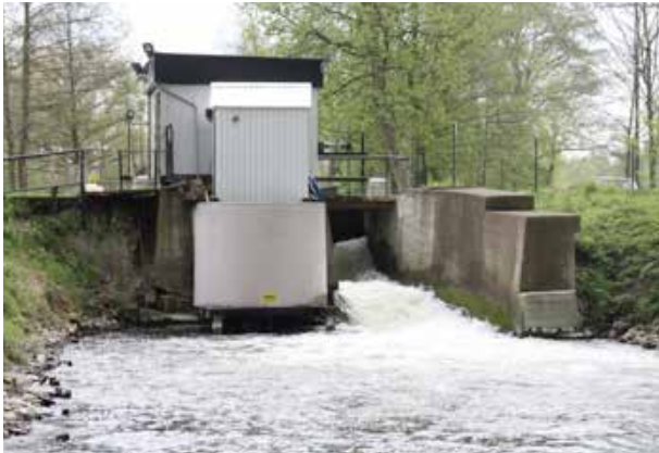
Wehr der abgängigen Hammermühle von Westen, April 2015
