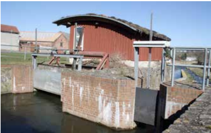
kl. Turbinenhaus auf Wehr der abgebrannten Tollensemühle von Südosten, März 2016
